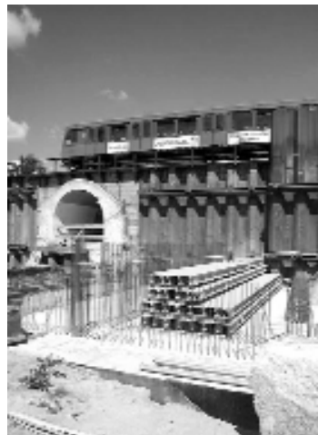
Bauarbeiten am S-Bahnhof Papestraße, Foto: Ingrid Strauch
