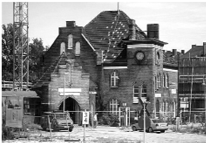
S-Bahnhof Papestraße, Altes Bahnhofsgebäude, Foto: Detlef Hoge
